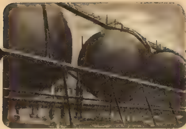
Amoniacul este depozitat în rezervoare metalice de formă sferică
